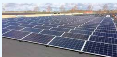
Installatie van zonnepanelen in Gits (BE) en Menemen (TU)
